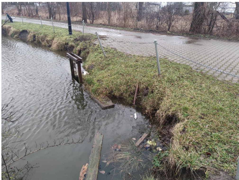
Fot. 6. Widok na ujęcie wody (mnich) zbiornika od strony południowo-wschodniej
